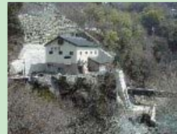
奥三面発電所(村上市)
