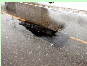
修繕工事により舗装し直された道路(周辺より黒くなっている四角い部分)。
