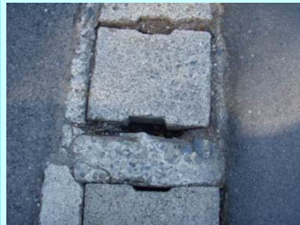
傷んだ側溝。土砂や粉じんが雪解け水で流れこみ詰まることも。
