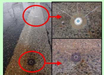
新しくなった消雪パイプのノズル(写真上)。壊れたノズルから順番に取り替えます。
