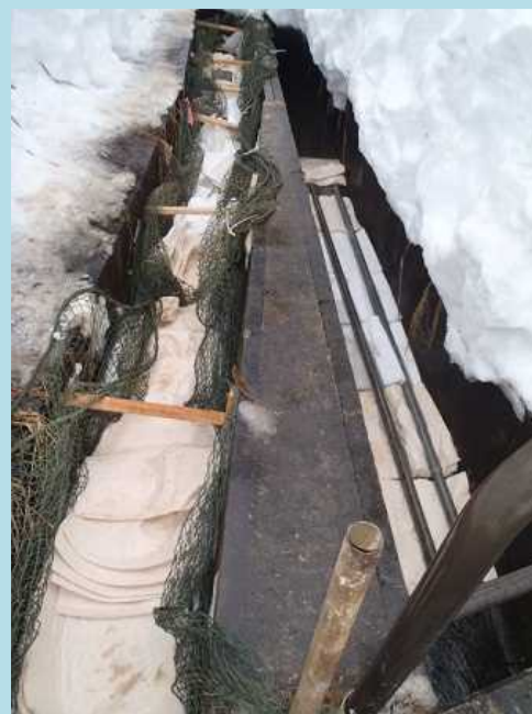
【水路に設置した吸着マット】
