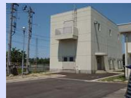
4号配水ポンプ棟(完成後)
