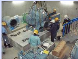
4号配水ポンプの搬入
