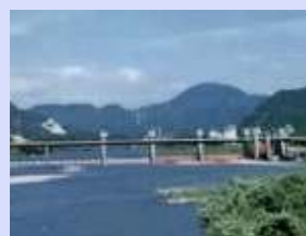
📷 阿賀野川頭首工(阿賀野市)
