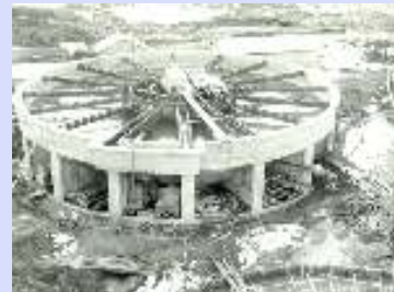
📷 上越工業用水道の建設の様子
