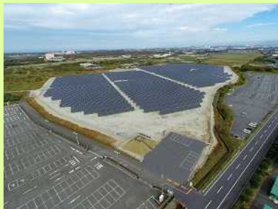
📷 平成26年11月28日に運転開始した北新潟太陽光発電所の全景
