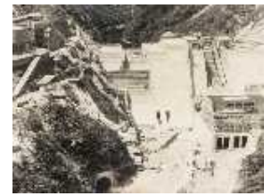
建設当時の三面ダムと三面発電所の様子 (旧朝日村、現在の村上市)
