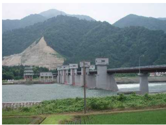
■取水口 (新潟臨海工業用水道)
