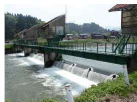
栃尾工業用水道 (長岡市)
