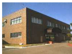
上越利水事務所 (上越市)
