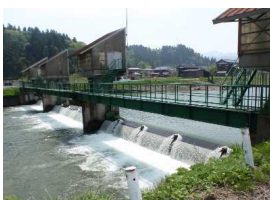
栃尾工業用水道（長岡市）
