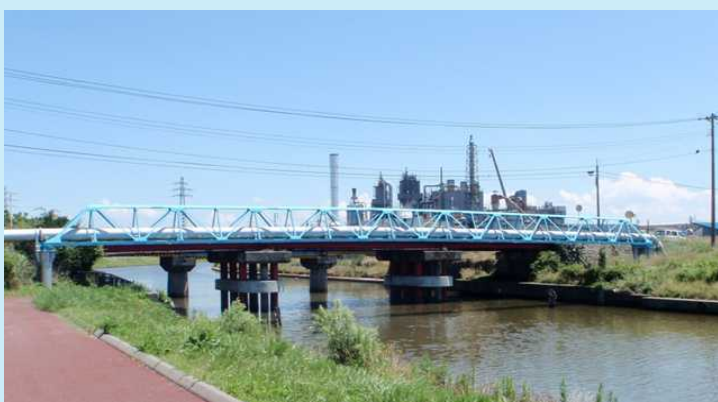
📷 今後架替え予定の通船川水管橋 （下流(手前)側に新設）
