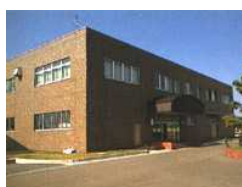
上越利水事務所 （上越市）
