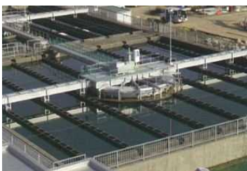
■高速凝集沈殿池 (新潟臨海工業水道) 薬品によって泥を集め、沈めます。浄化された水が工業用水になります。
