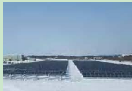
太陽電池モジュール(パネル)の設置枚数は4,822枚、敷地面積は約3.2ha。
