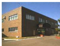
上越利水事務所 (上越市)
