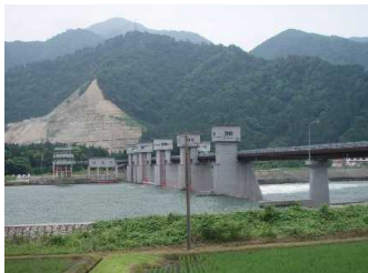
■取水口 (新潟臨海工業用水道)
